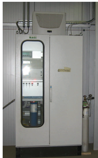
KNAUF INSULATION (TERMO) Škofja Loka, Slovenia Proizvodnja kamene volne, AMS: CO, CO 2 , O 2 , prah, O 2 (In-situ) ČISTILNA NAPRAVA ODPADNIH PLINOV KUPOLNE PEČI
