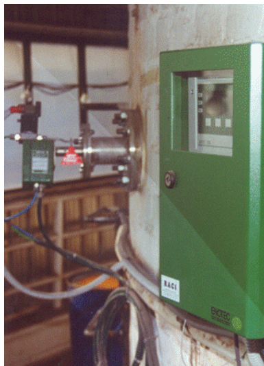
TERMOELEKTRARNA TOPLARNA Ljubljana, velika kurilna naprava AMS: vlaga (H 2 O) - suho/vlažna metoda (vsebnost O 2 )
