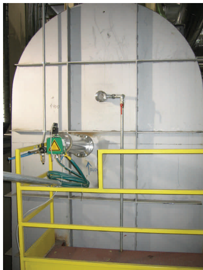
KNAUF INSULATION (TERMO) Škofja Loka, Slovenia Proizvodnja kamene volne, AMS: CO, CO 2 , O 2 , prah, O 2 (In-situ) ČISTILNA NAPRAVA ODPADNIH PLINOV KUPOLNE PEČI
