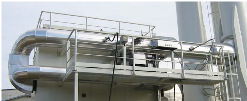
primerjalne meritve z mobilnim sistemom in sistemom trajnih meritev EN 14181 – QAL 2
