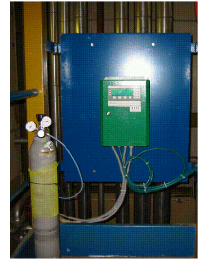
TOM Maribor, 2003 vročevodni kotel, sanacija regulacijskih zank vključno z O 2 regulacijo - merilnik koncentracije kisika v sodelovanju s
