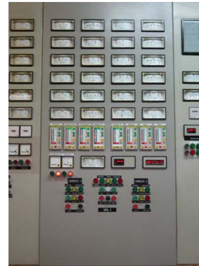
TOM Maribor, 2003 vročevodni kotel, sanacija regulacijskih zank vključno z O 2 regulacijo - SIPART regulatorji
