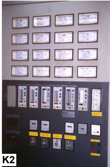
TOVARNA SLADKORJA ORMOŽ, 1995 in 1997 parni kotel, sanacija regulacijskih zank vključno z O 2 regulacijo - SIPART regulatorji
