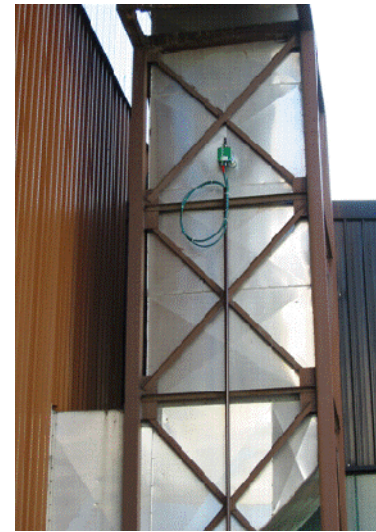
TOM Maribor, 2003 vročevodni kotel, sanacija regulacijskih zank vključno z O 2 regulacijo - merilnik koncentracije kisika v sodelovanju s
