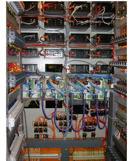
TOM Maribor, 2003 vročevodni kotel, sanacija regulacijskih zank vključno z O 2 regulacijo - SIPART regulatorji
